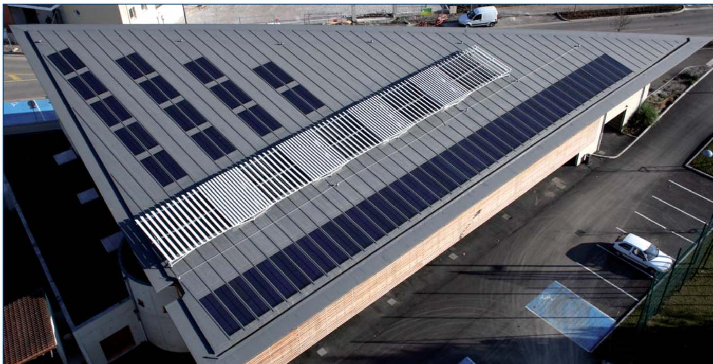
Photo 3T-Alwitra: Ces cellules sont protégées par film en polymère fluoré autonettoyant. La sous-face est en feutre polyester. Il faut 20 à 23 m<sup>2</sup> de membrane Evalon® Solar pour assurer une puissance photovoltaïque de 1 kWc.
