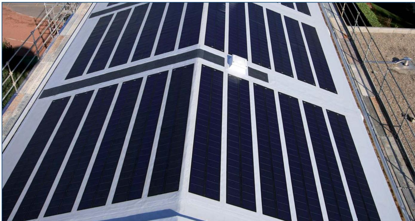
Photo 3T-Alwitra: Certaines zones doivent être prévues sans film photovoltaïque. Des distances minimales doivent être respectées: 0,50 m en périphérie de toiture et de certains ouvrages émergents (lanterneaux, cheminées), 1 m des équipements tels que les climatiseurs, 2 m pour les zones techniques...
