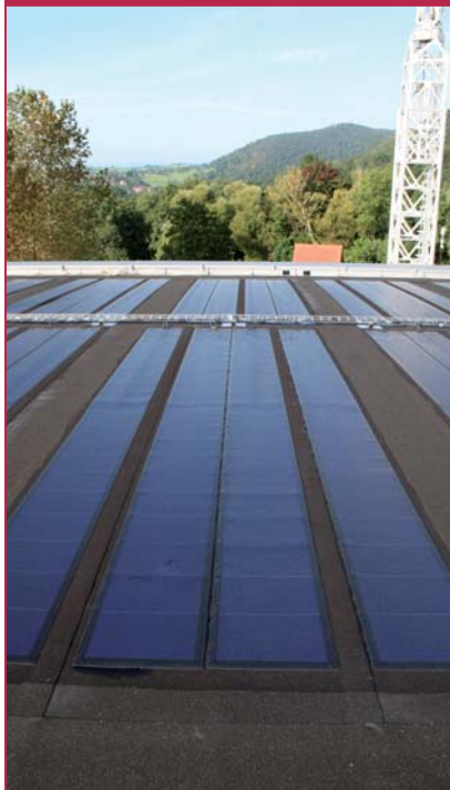
Photo Solaris/Soprema : Bandes de cellules minces et souples en silicium amorphe collées sur une étanchéité en toiture-terrasse de type bicouche à base de bitume élastomère.
