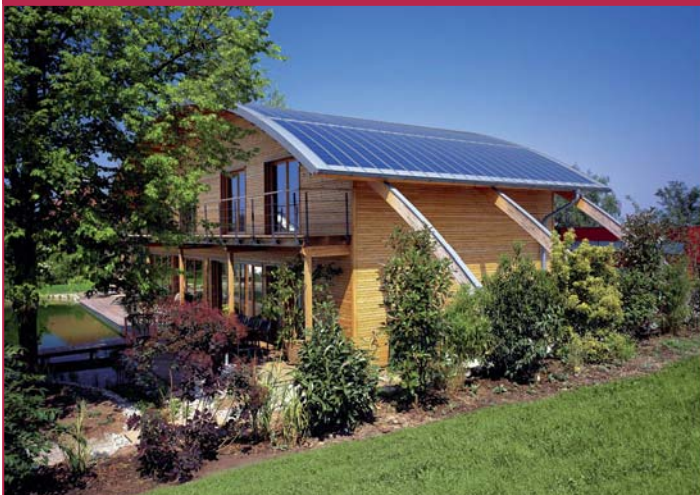
Photos Rheinzink - Photo de gauche : Couverture en zinc « à joint debout » : les bacs cintrés supportent une couche mince - sans vitrage - de cellules en silicium amorphe.
