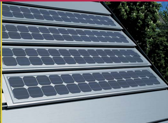
Photo de droite : Couverture en zinc « à gradins » horizontaux : le laminé photovoltaïque, avec verre et cellules en silicium cristallin, est collé sur les bacs.
