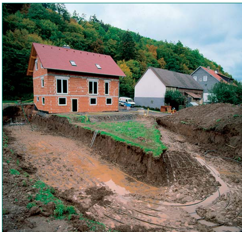
Photo Viessmann : Pac géothermique à capteurs horizontaux.
